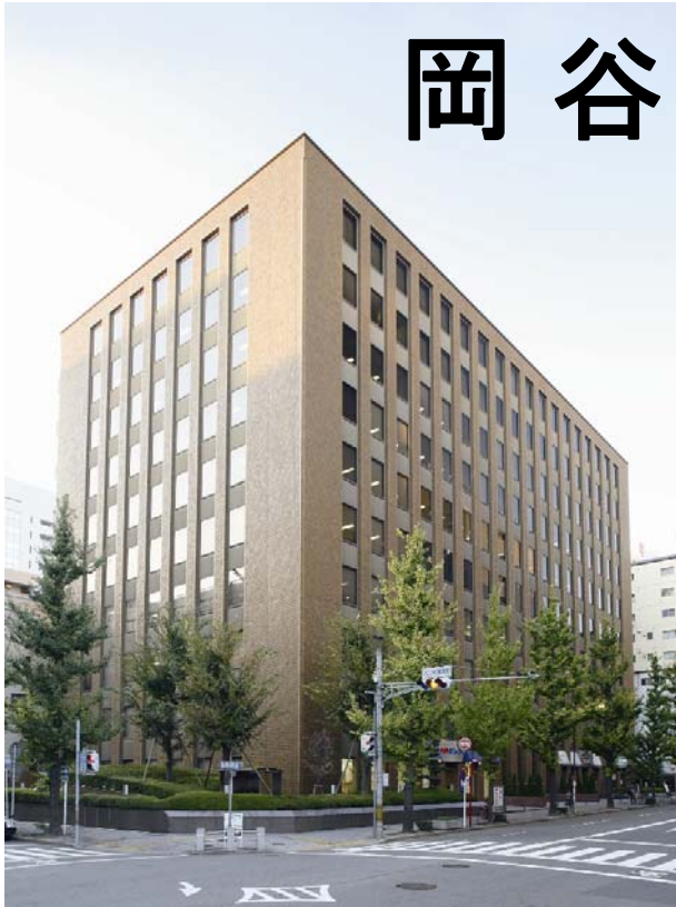
栄 名古屋本社ビル
