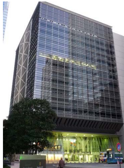
東京本店丸の内中央ビル
