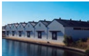
中川配送センター
